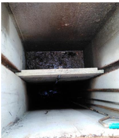
Pohled do stavidla
